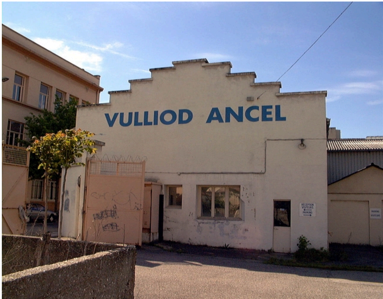
Entrée principale rue Montbrillant : pignon à redent
