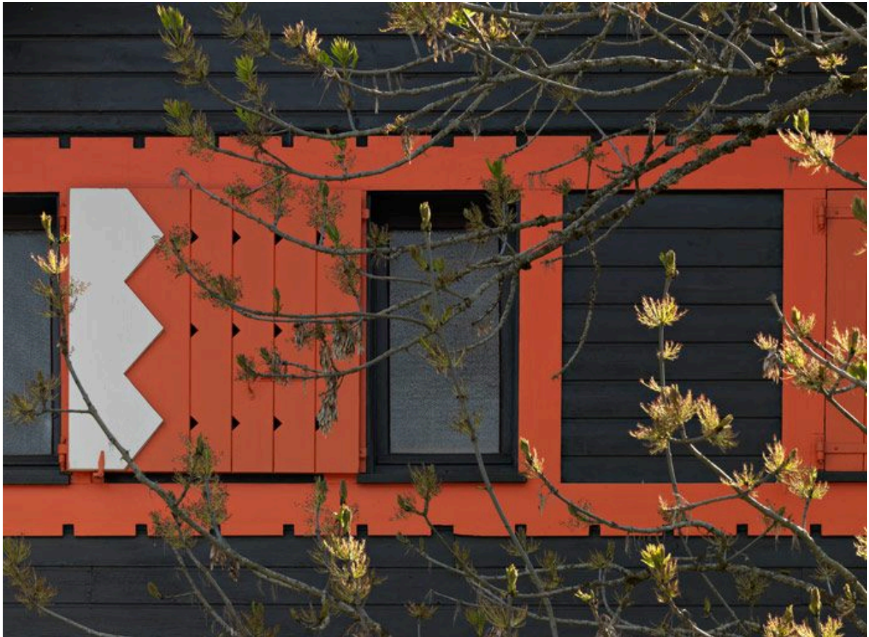
Chalet la Chaumette, 31 route du Téléphérique. Façade latérale. Détail des volets
