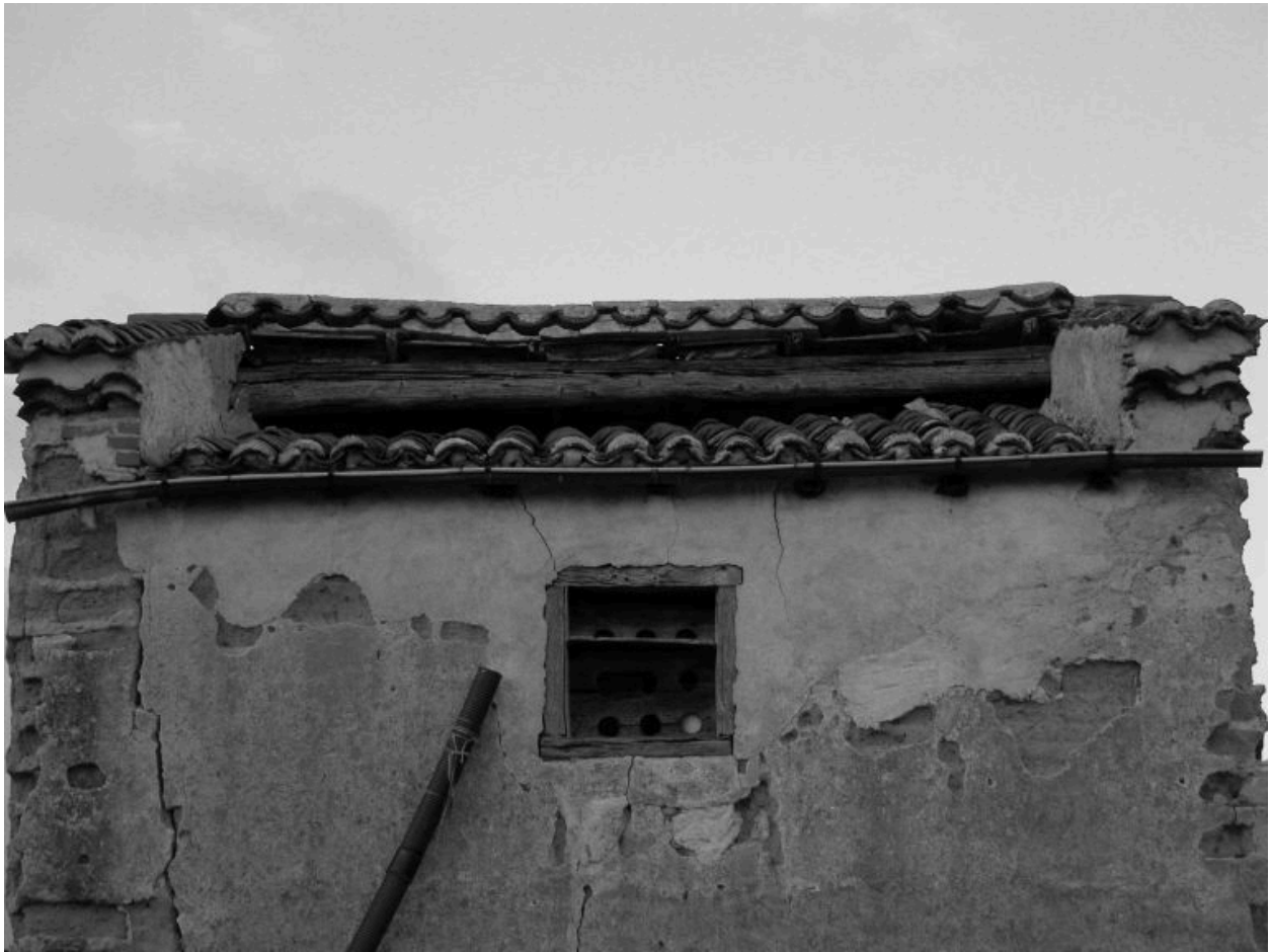
Vue partielle de la partie haute du mur gouttereau sud.
