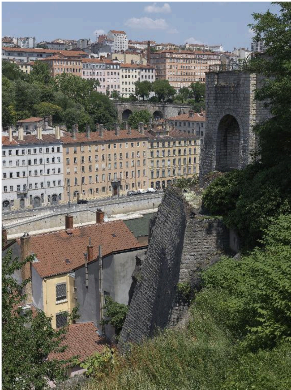
Vue des murs de soutènement de la terrasse, depuis l'ouest
