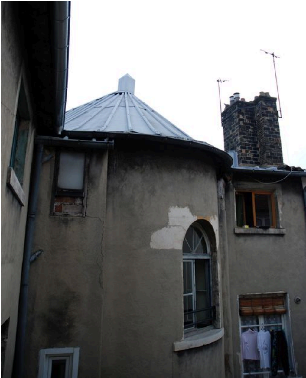
Elévation sur cour, le sommet de la tour d'escalier
