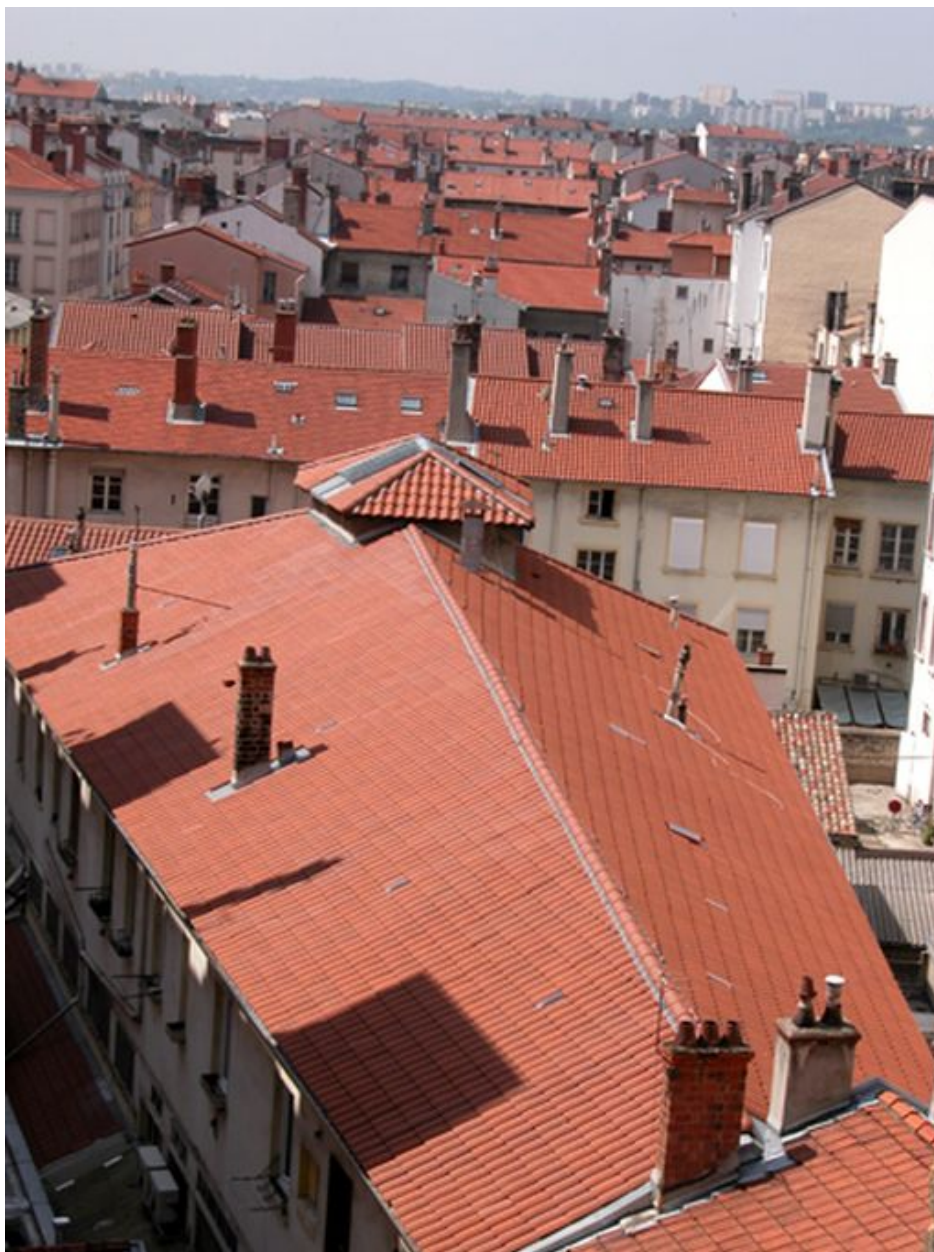
Vue des toits depuis le 4 avenue Jean-Jaurès
