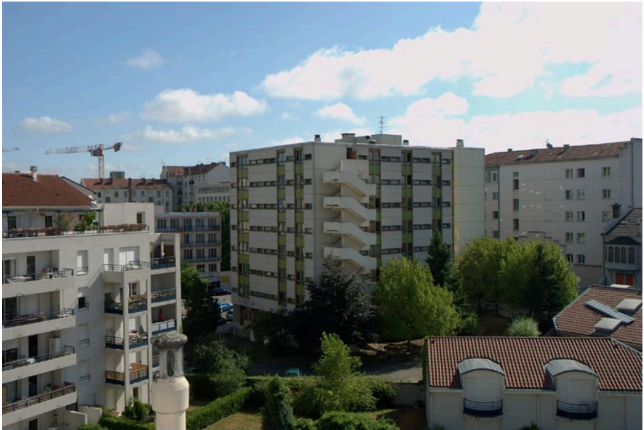
Vue générale depuis le toit de l'immeuble 19 rue Claude-Veyron, au sud-ouest
