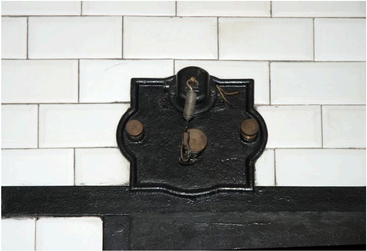
Four, élément métallique
