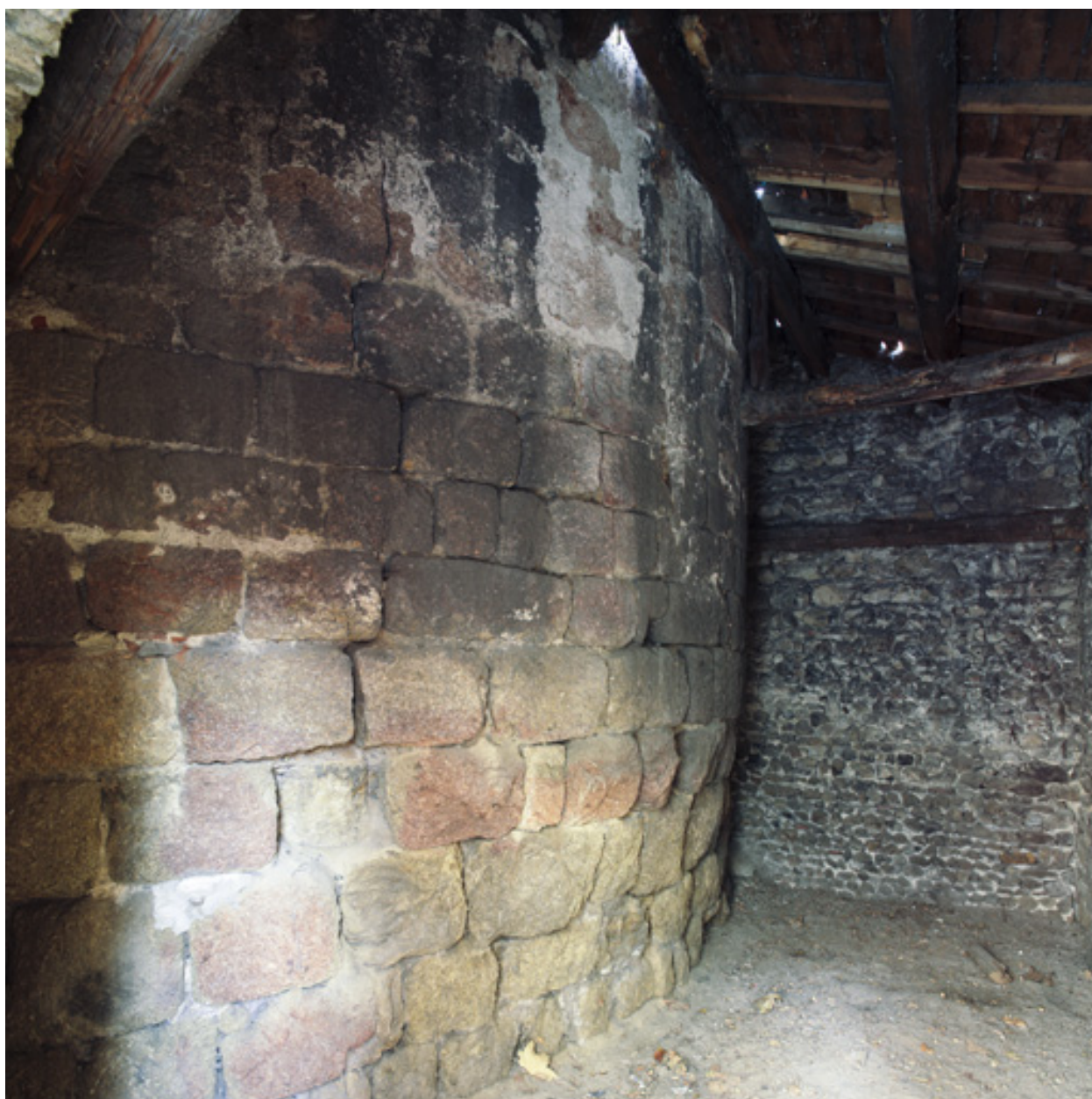
Détail de la base de la tour visible depuis le corps de passage.
