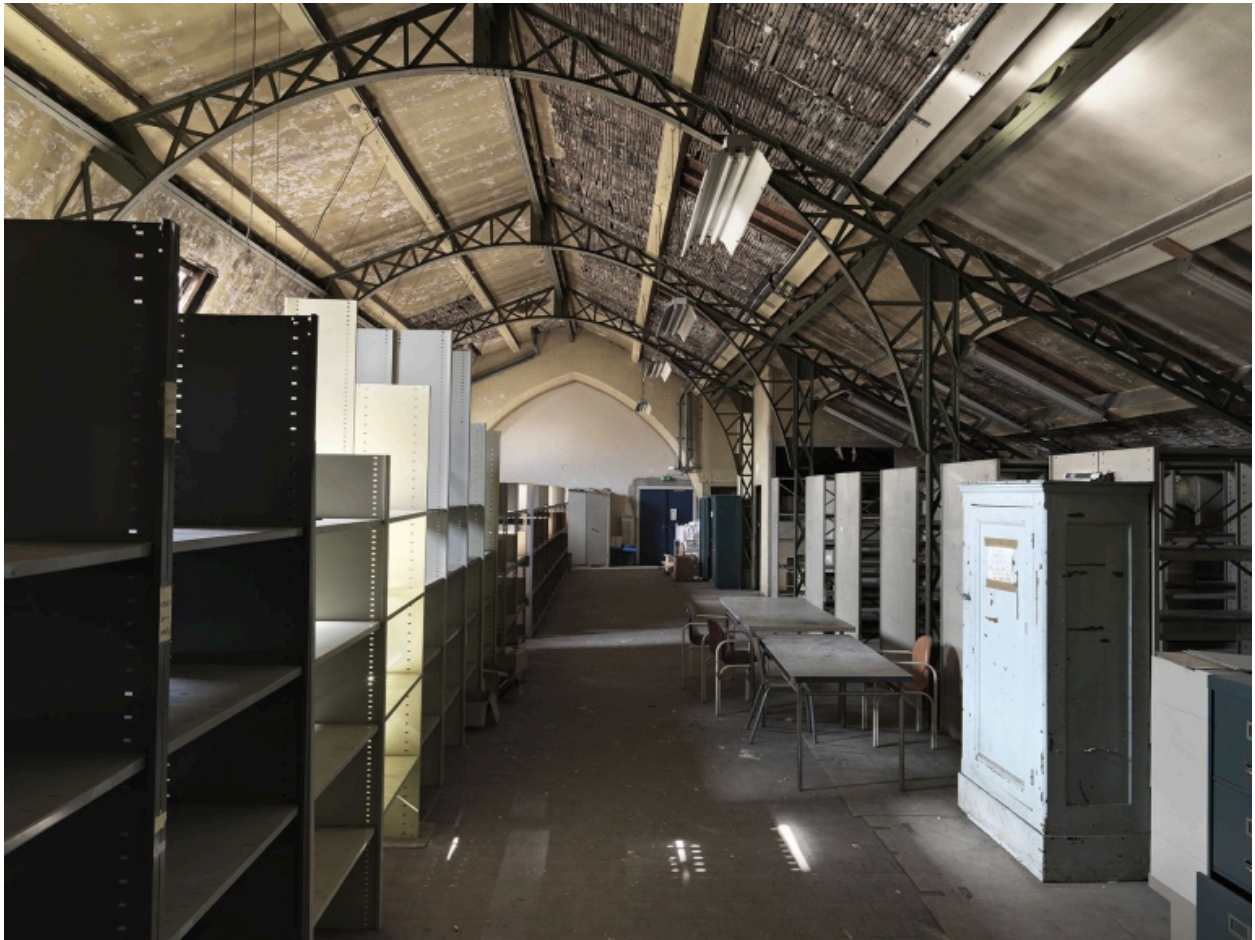
Bâtiment C. 4e étage. Salle des archives
