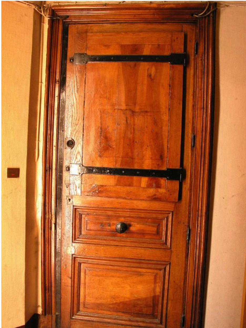
Rez-de-chaussée : détail d'une porte palière
