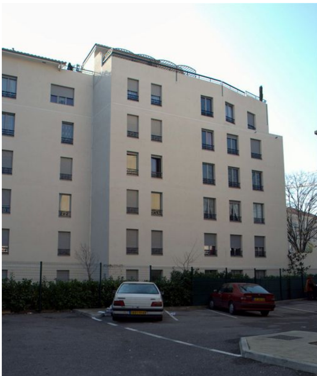
Elévation postérieure, vue partielle (13 rue Jules-Brunard)
