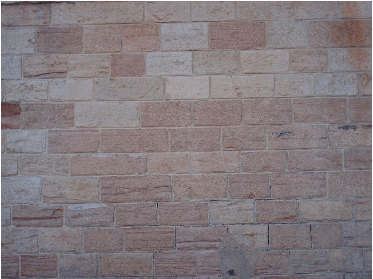
Etat en 2010 : détail de matériaux
