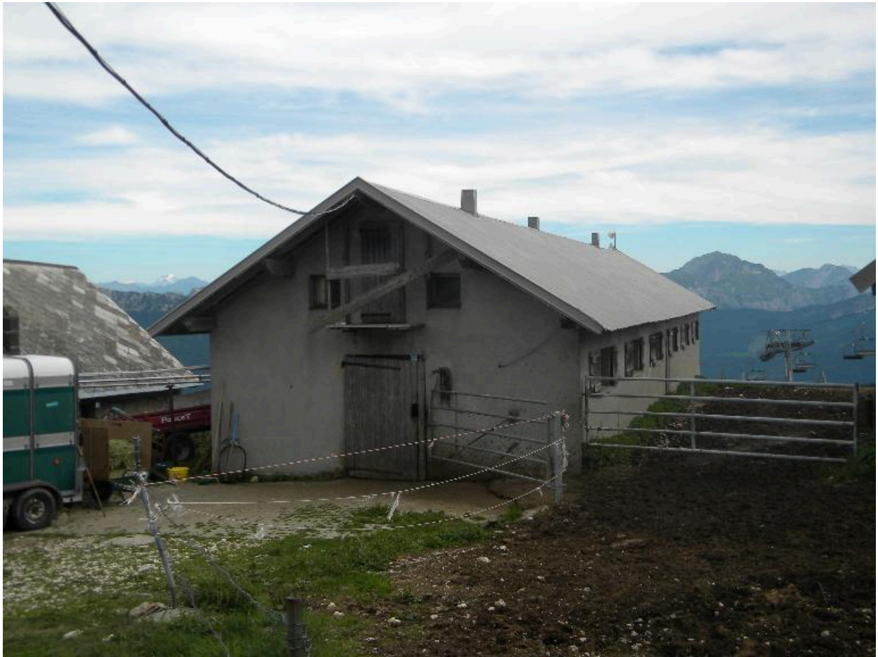
Vue de l'étable centrale en ciment.
