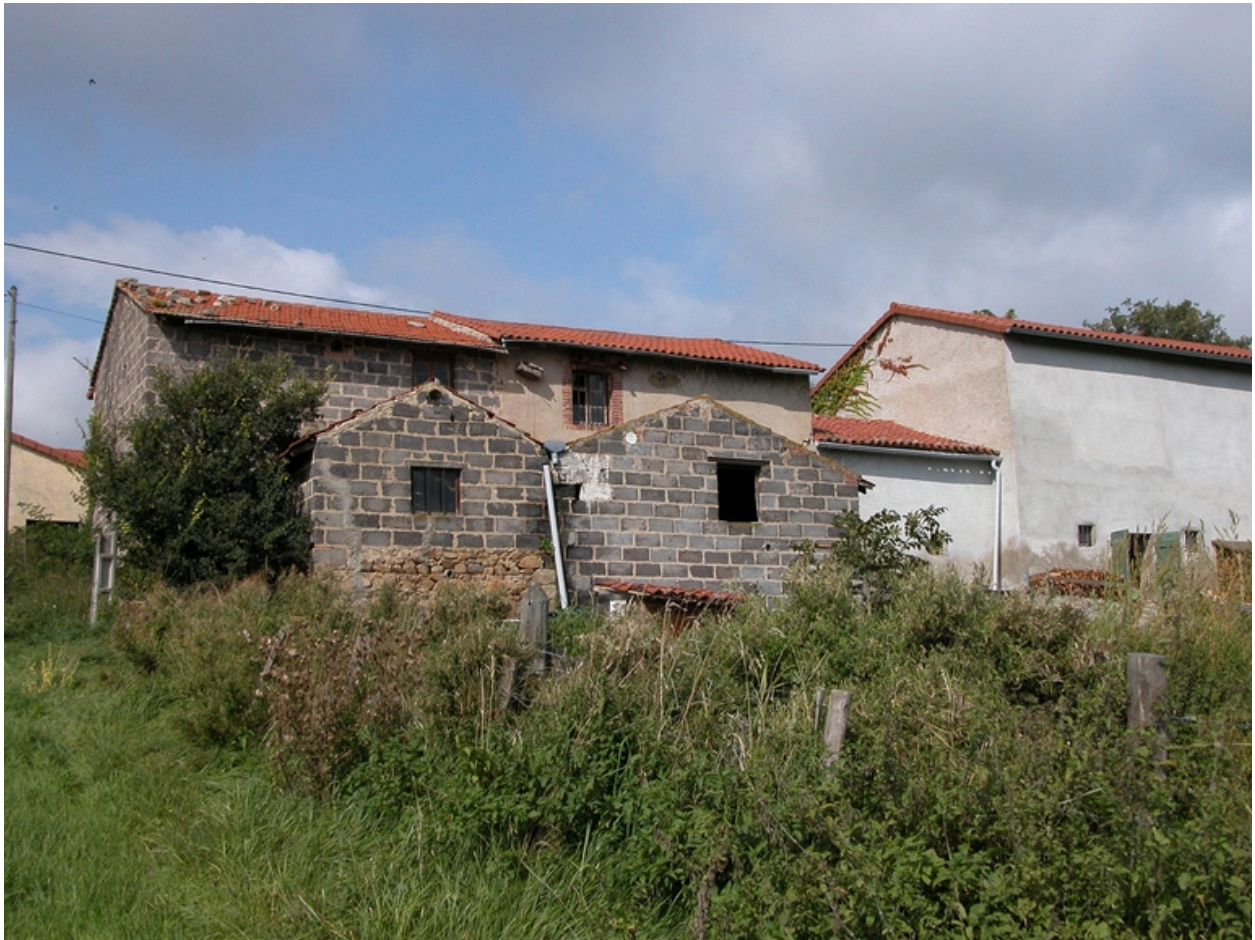
Vue de la parcelle 1984 A 1358, depuis le sud-est.
