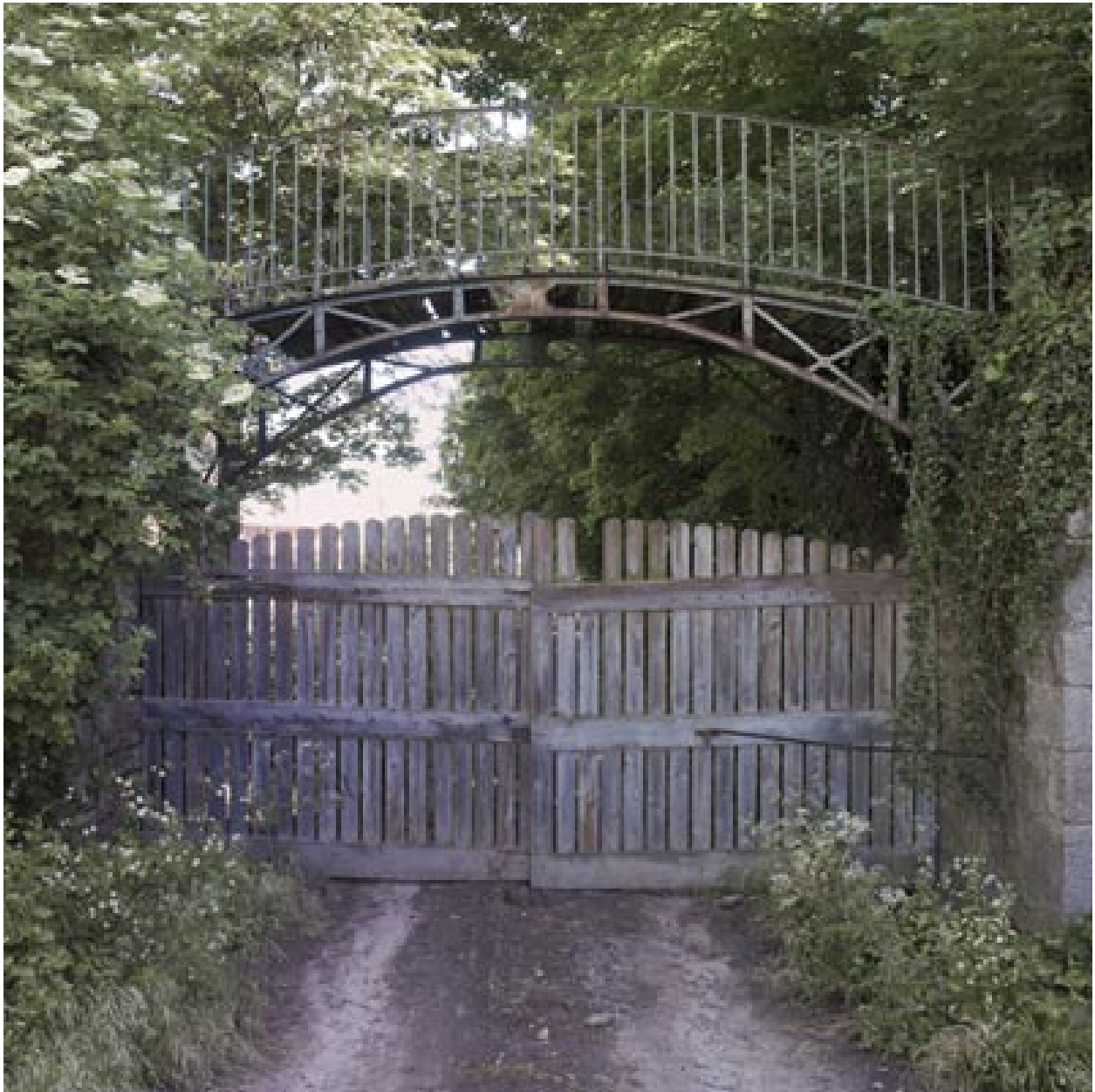
Portail est, avec passerelle en charpente métallique.
