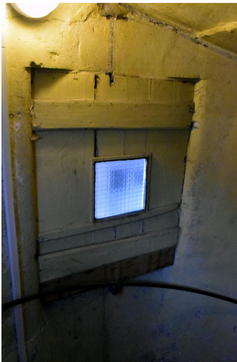
Tour d'escalier : fenestron
