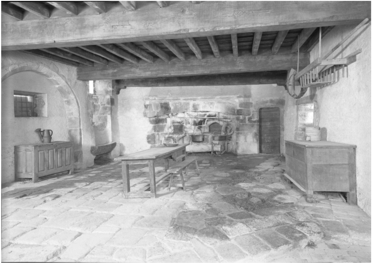
Corps de galerie, rez-de-chaussée, portique : vue intérieure de la troisième pièce du portique dite "les cuisines", du sud.
