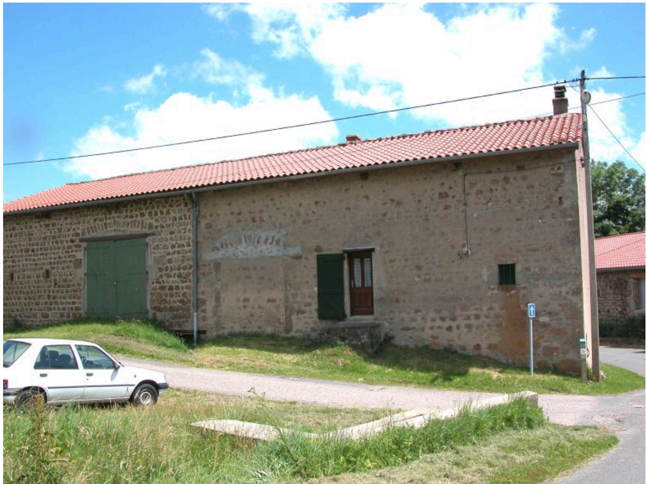
Vue d'ensemble arrière gauche de la ferme.
