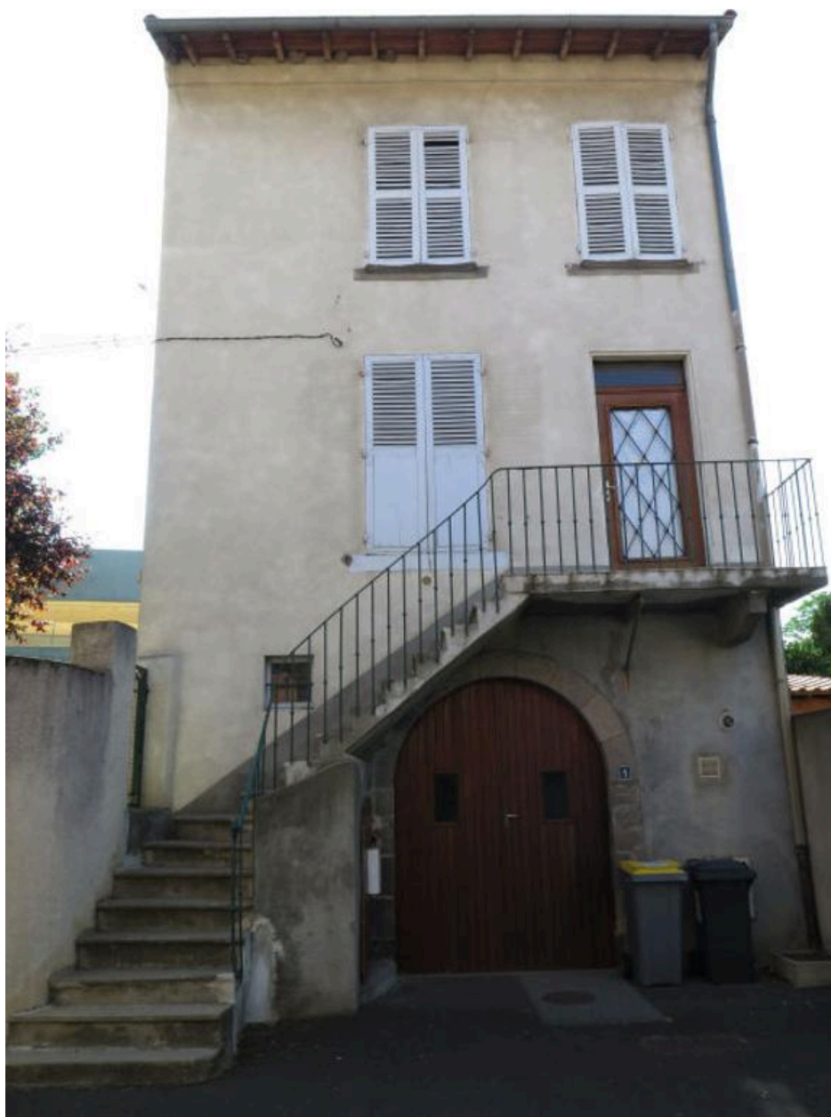
Type "en hauteur" à escalier (Pérignat, 2 rue de Romagnat)
