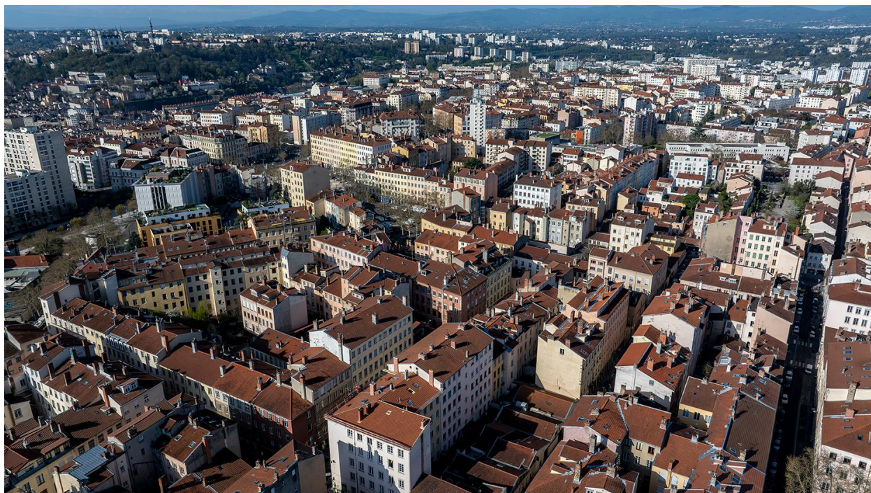
Vue d'ensemble secteur des immeubles-ateliers (vue drone)
