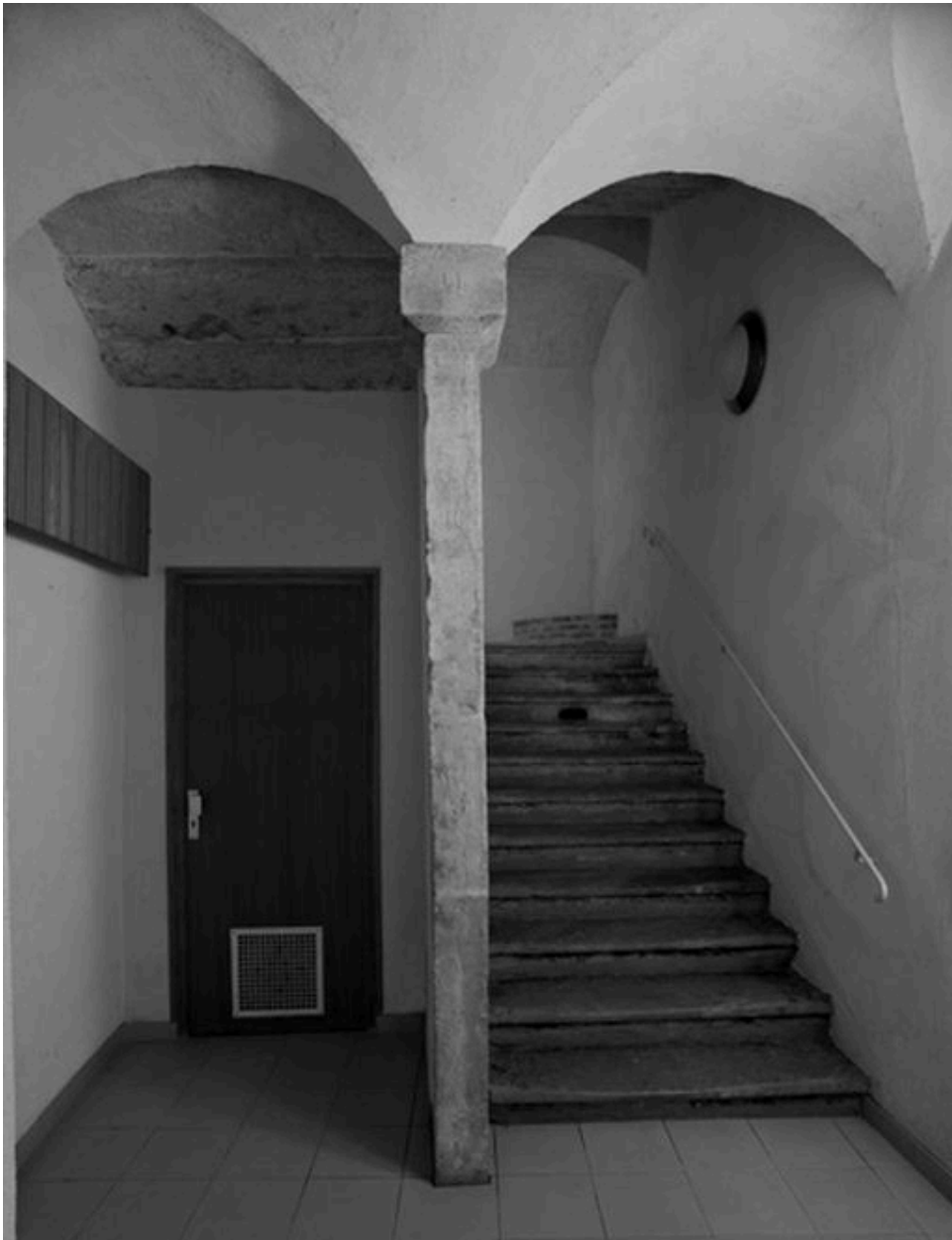
Vue de l'escalier
