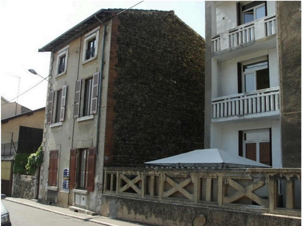
façade sud est
