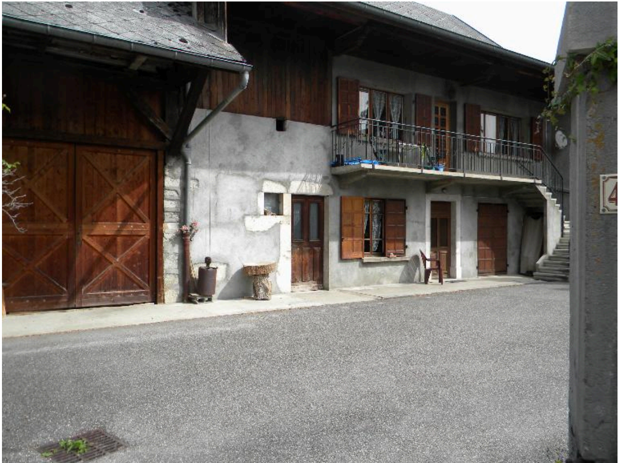
Vue du logis d'une ancienne ferme (2008 B2 1936)
