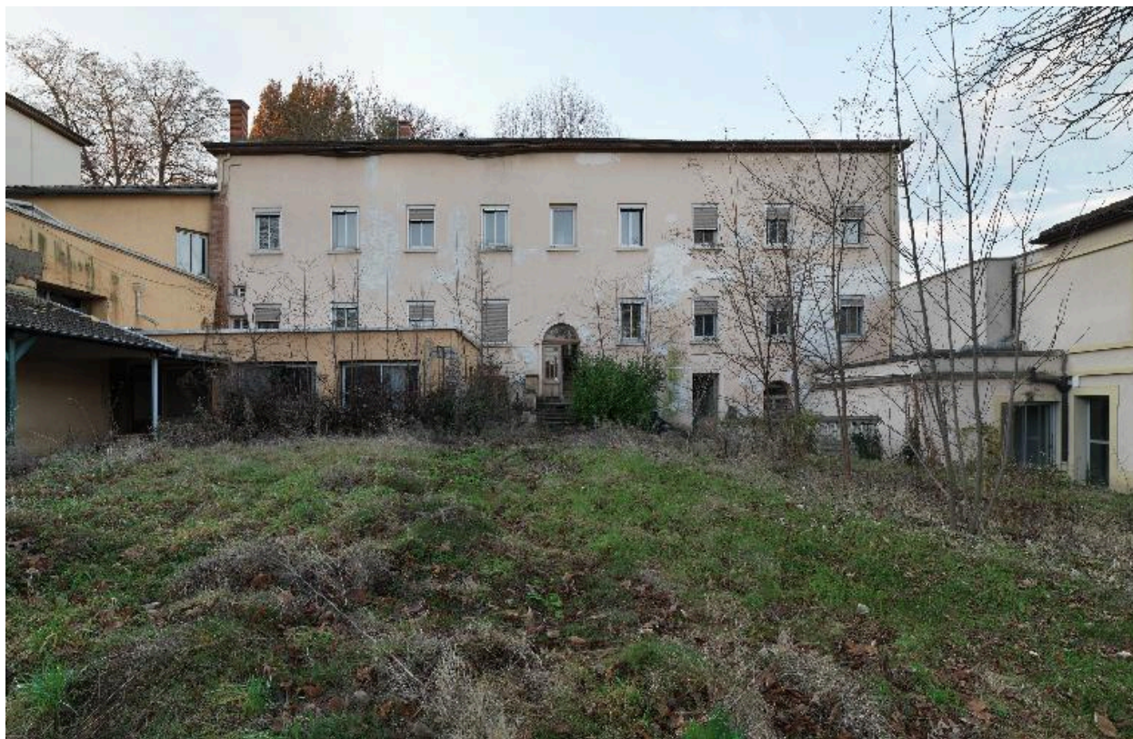
Bâtiment nord, élévation orientale et vue partielle des adjonctions sur l'arrière
