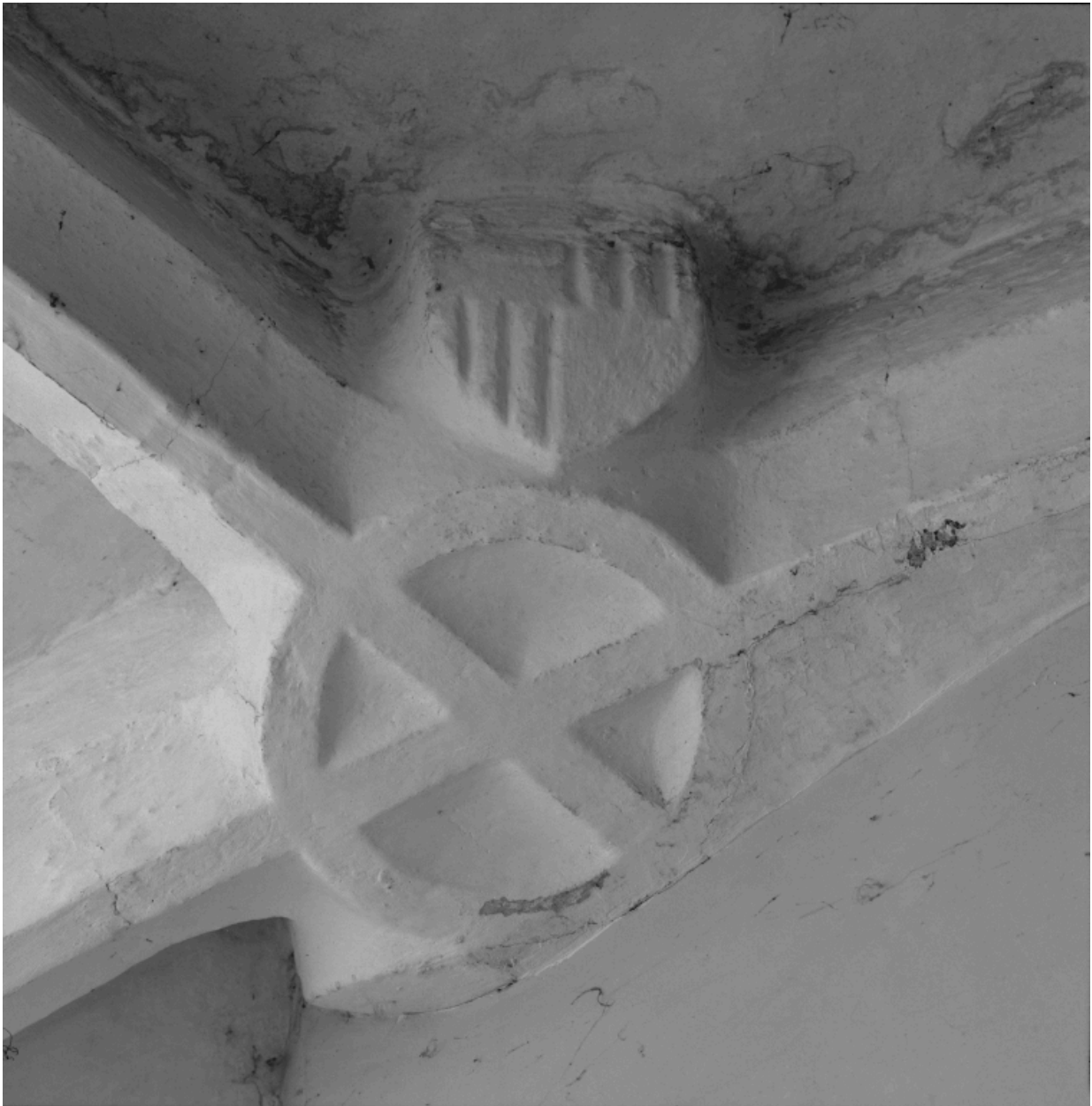
Clef de voûte de la sacristie.
