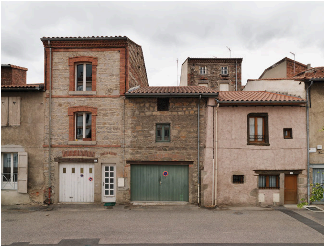
Vue générale (maison de droite)
