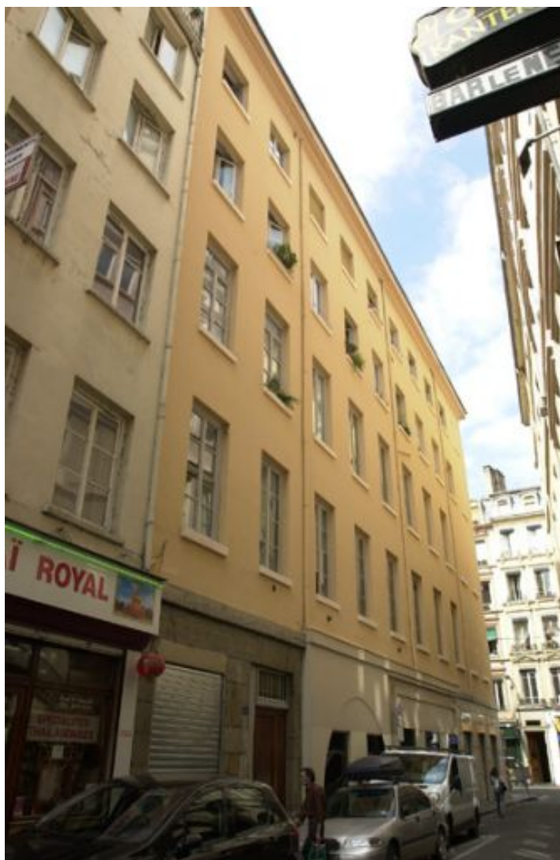
Façade principale rue de la Poulallerie
