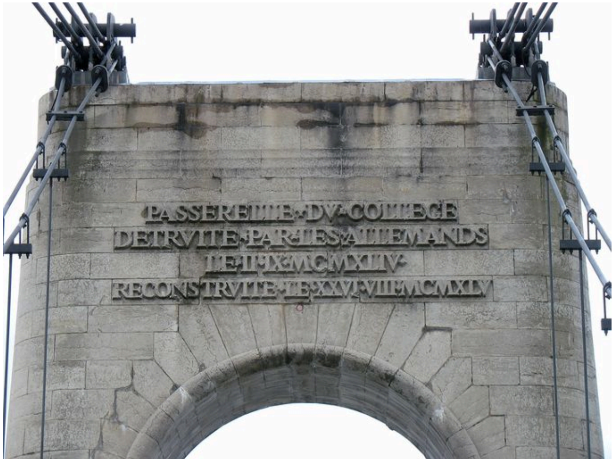
Pylône, vue partielle : inscription
