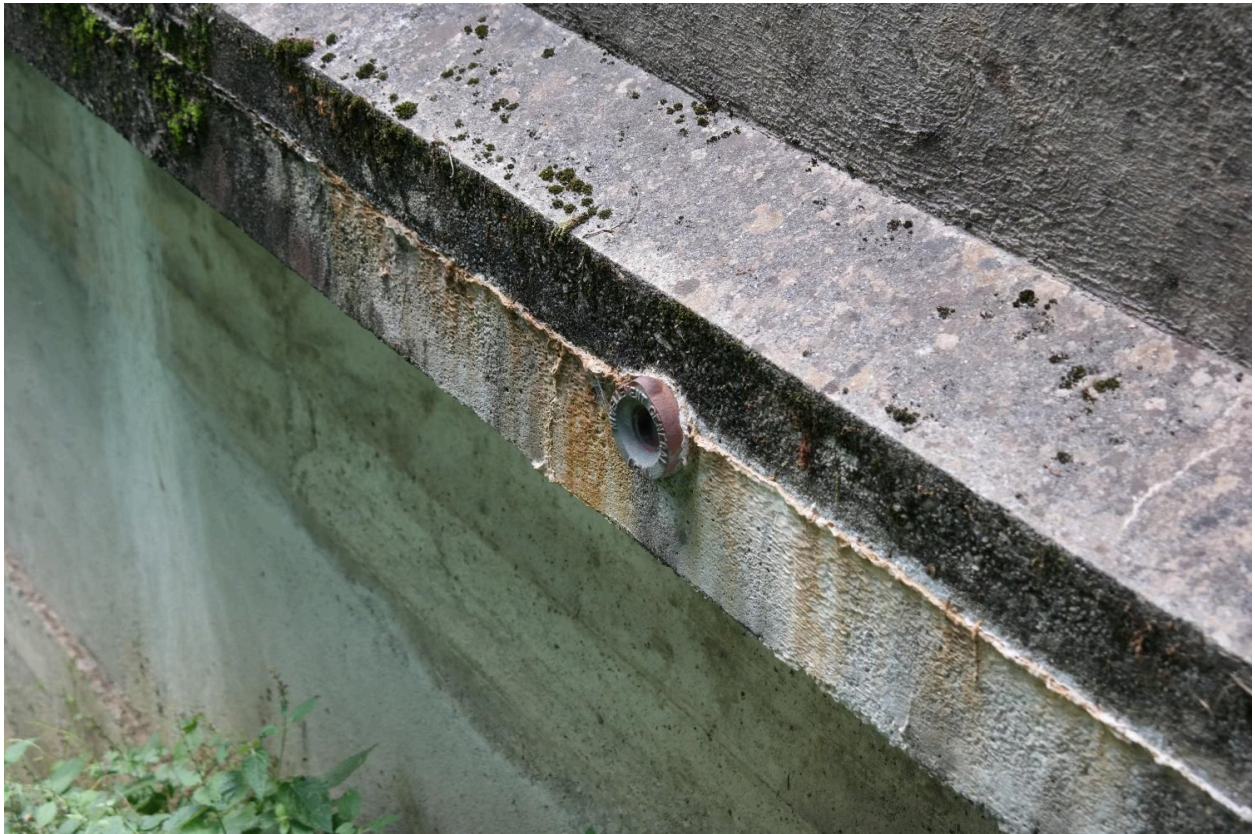
Pont du Paramnd 1, détail d'une brone géodésique
