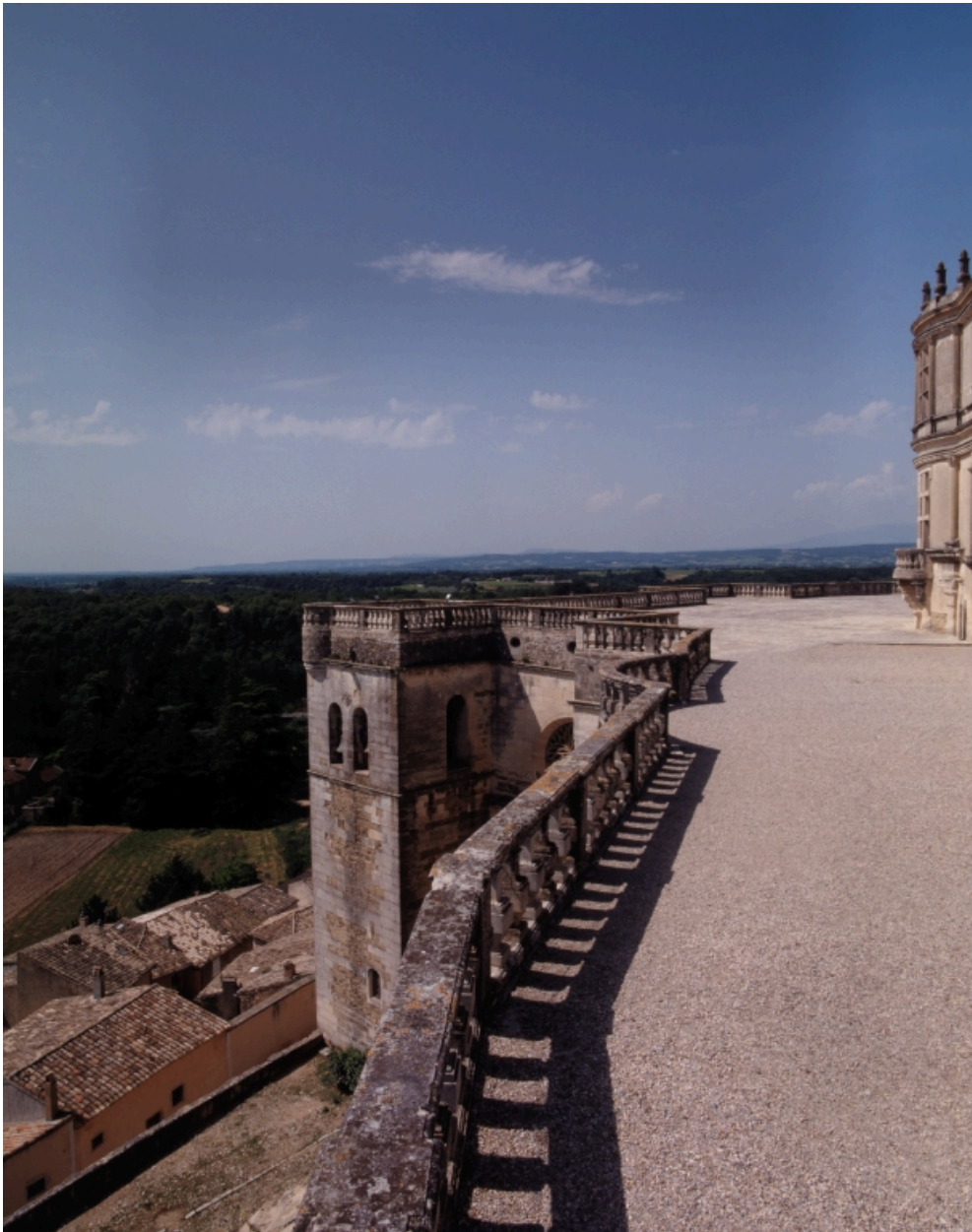
Terrasse. Vue d'ensemble prise depuis le nord.
