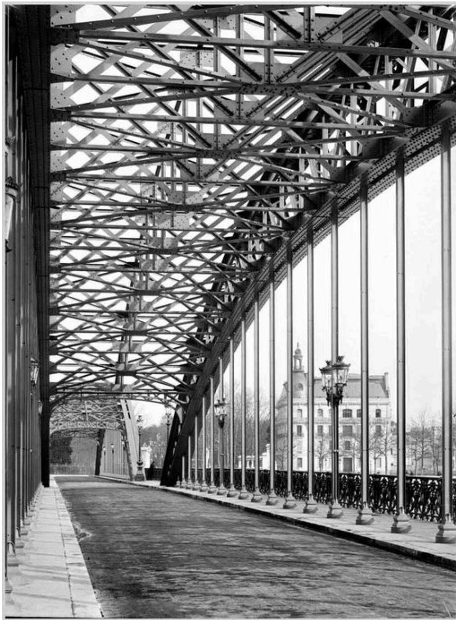
Le pont de la Boucle achevé. Vue du tablier. [1903]. 1 fotogr. : n. et b. (AM Lyon. 15 Ph 1843)
