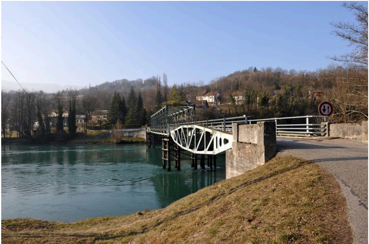
Vue générale, face aval (depuis la rive gauche)
