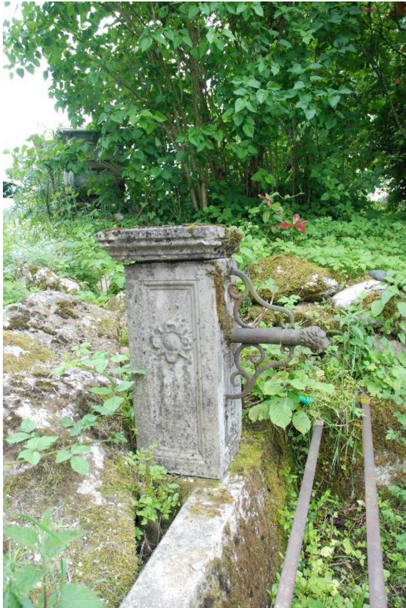
Détail de la borne-fontaine.
