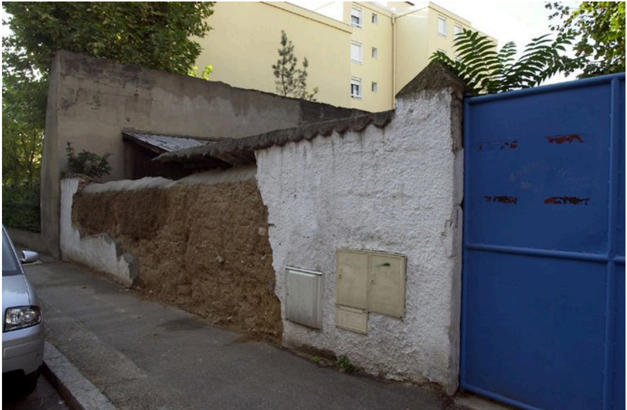
Le mur de clôture en pisé
