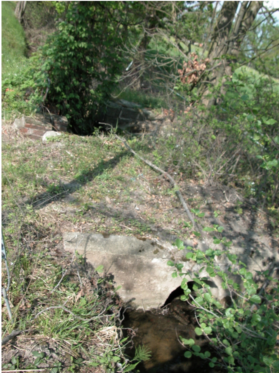
Artériole du canal du Forez à Chantegrelet : ponceau (section 1997 AL).
