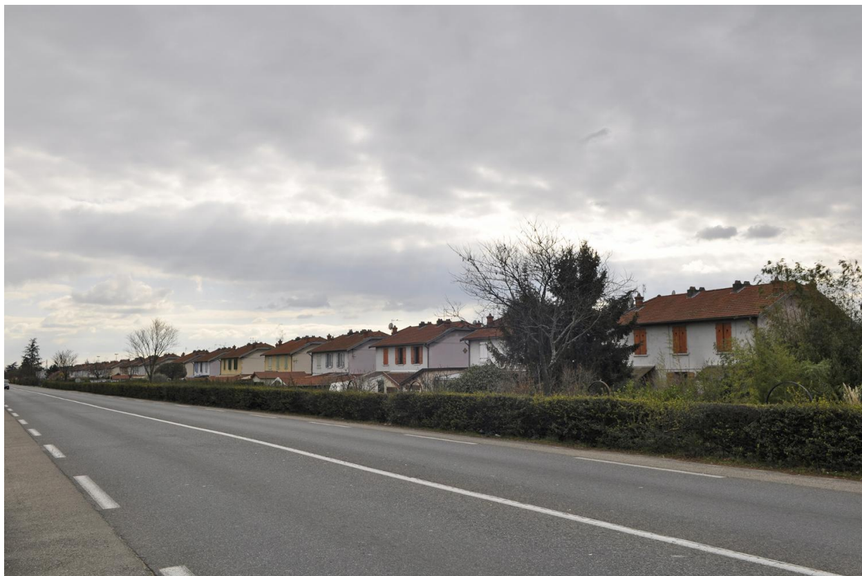
Alignement de maisons ouvrières au bord d'une route nationale 7 (vue sud)
