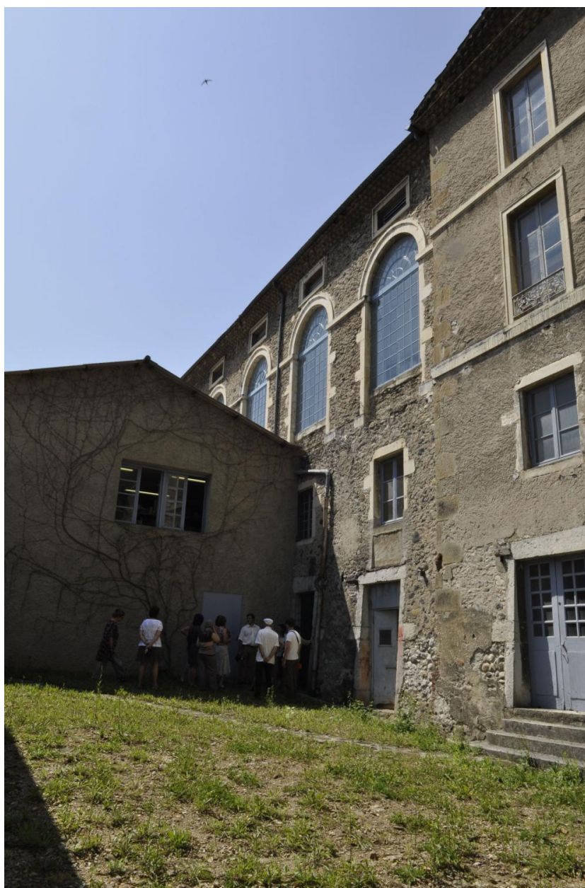
Corps de bâtiment annexe (vue d'extérieur)
