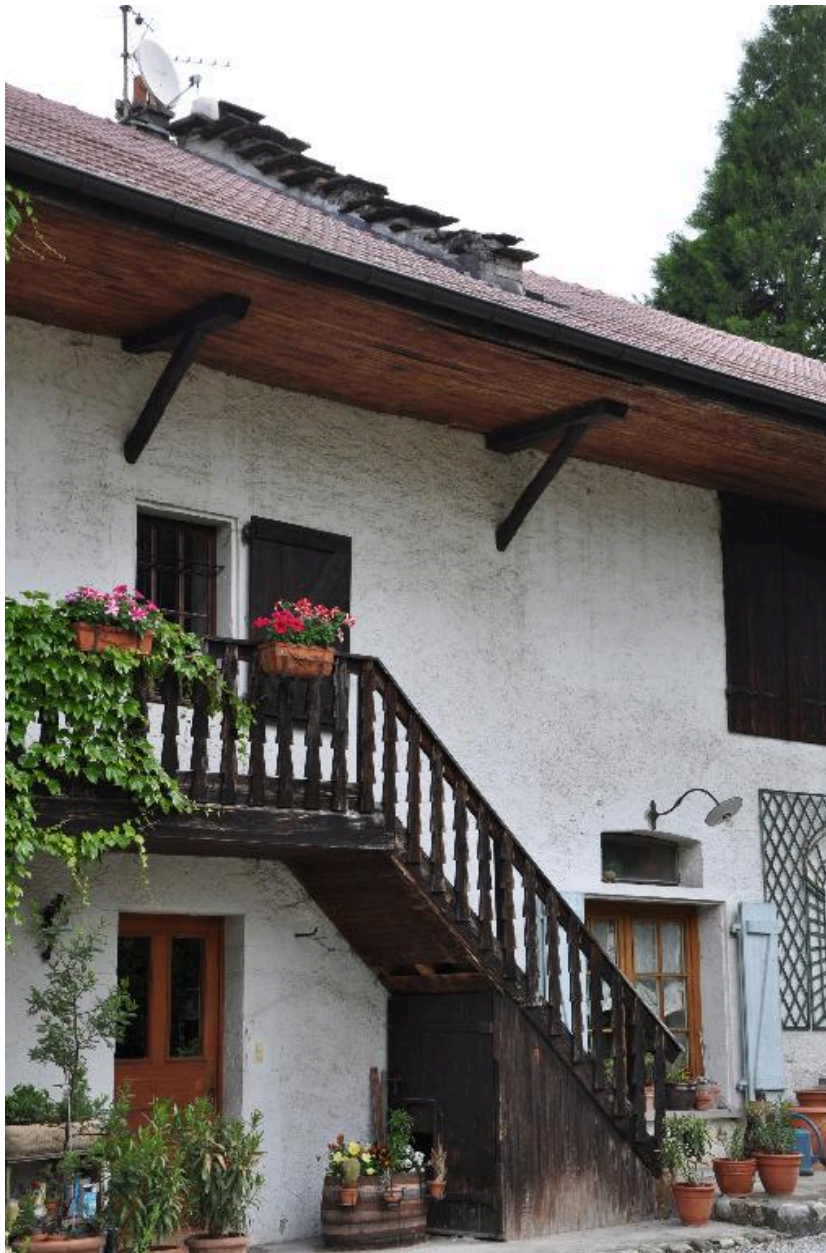
Escalier de distribution extérieur en bois
