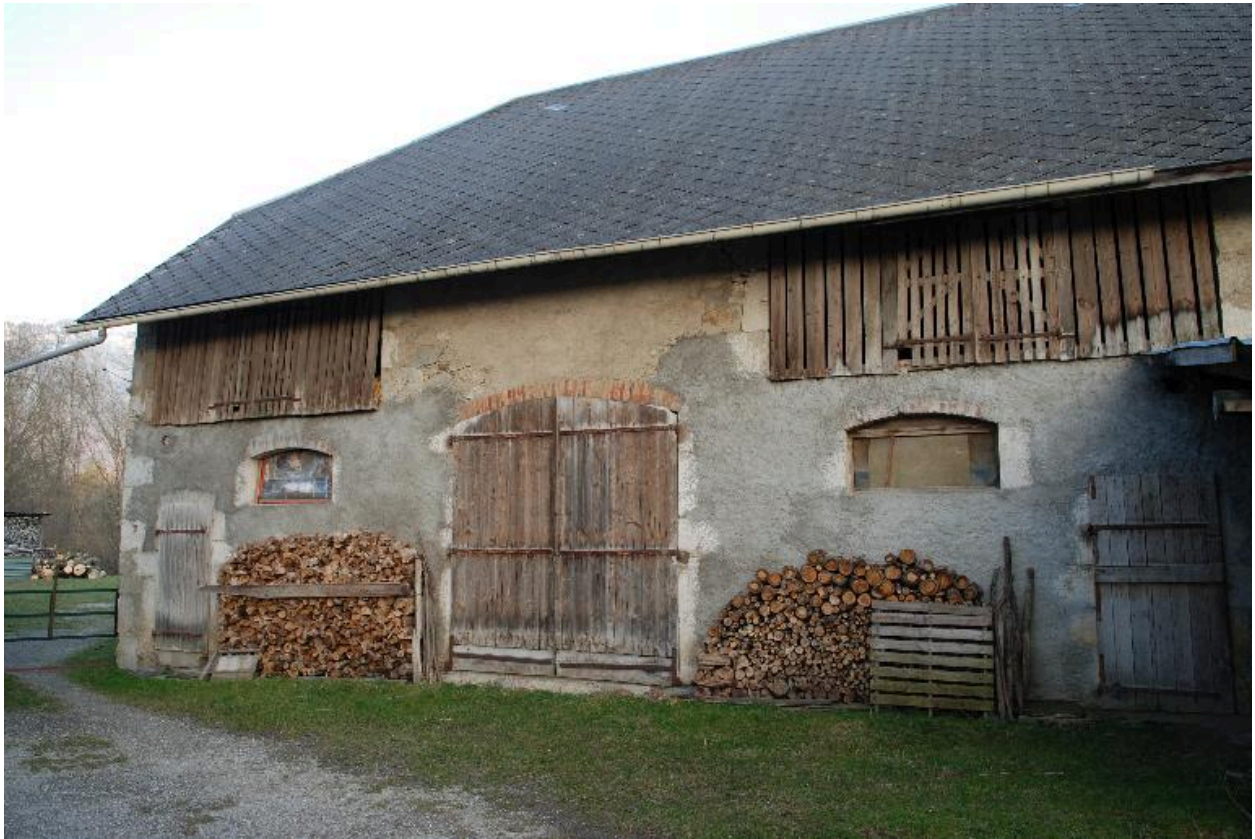
Vue d'ensemble de l'élévation arrière des communs.
