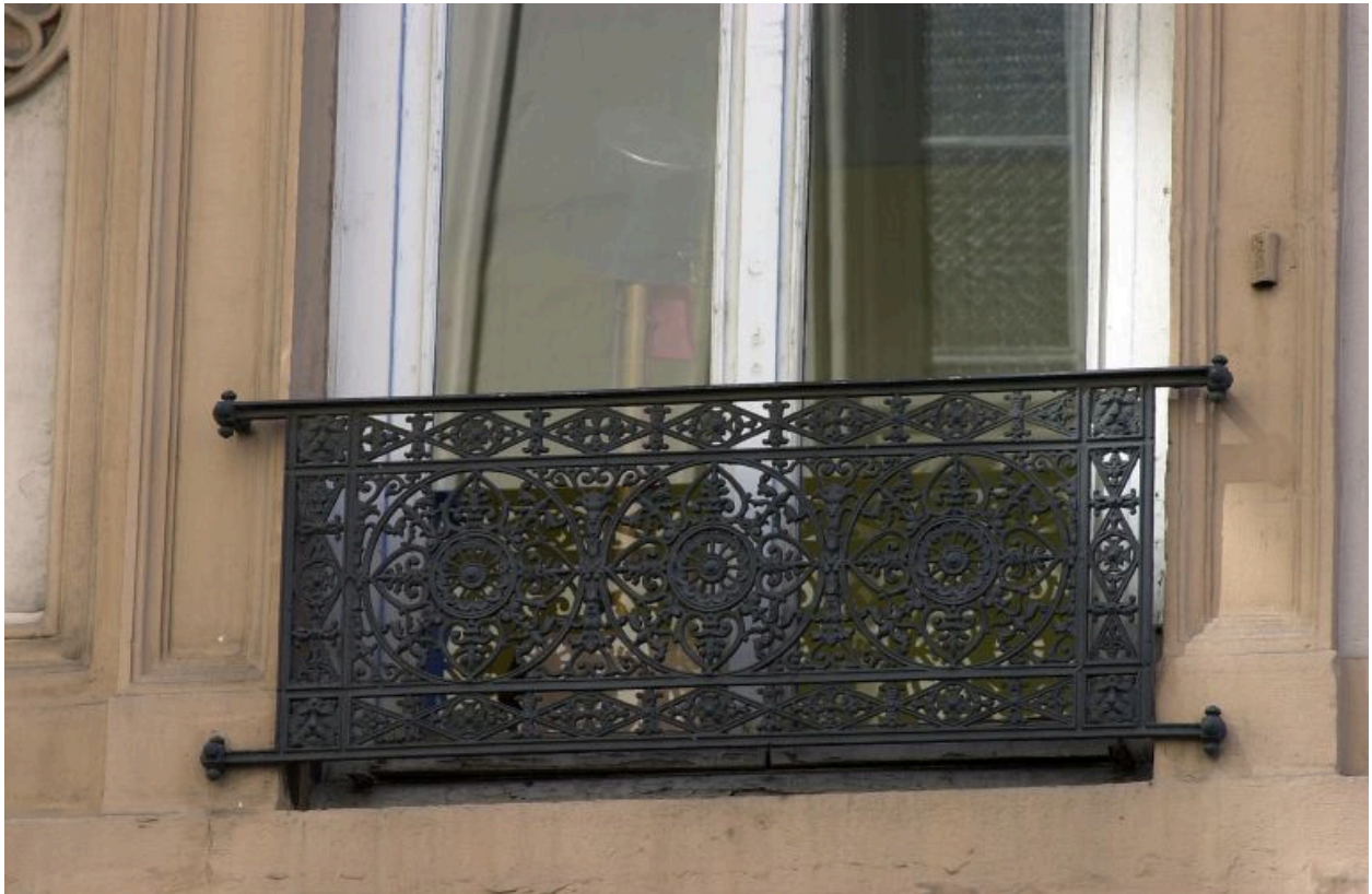
Façade sur la rue des Bouquetiers, 2e niveau, garde-corps de la dernière fenêtre
