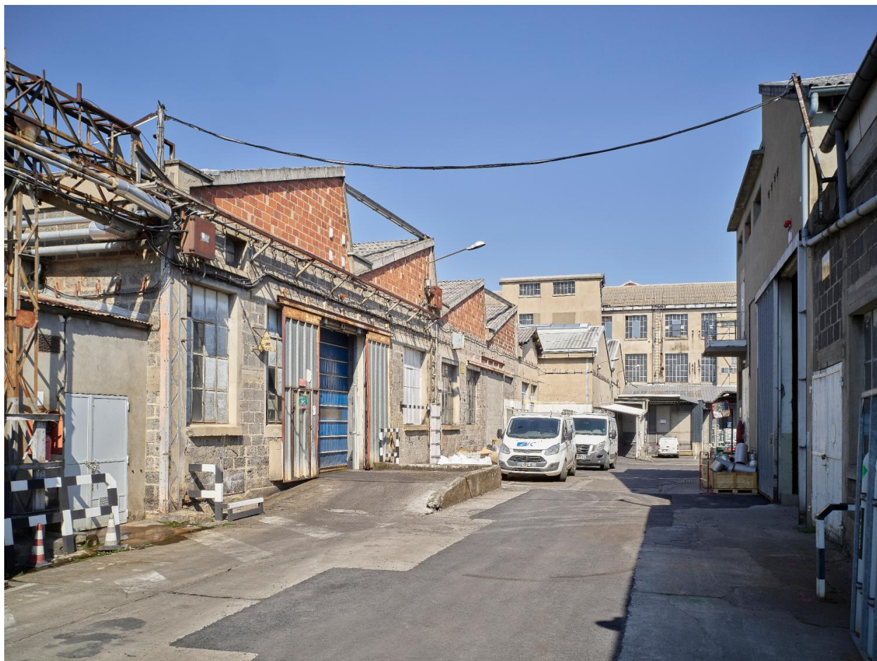
Élévation sud du bâtiment B70, rue de Saurier ; à l'arrière-plan, les ateliers de Z36.
