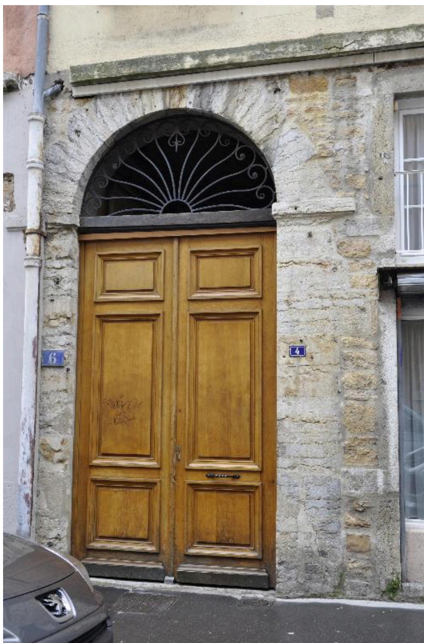
Porte de l'immeuble du n°4 rue Dumenge et du n°6 rue Dumenge
