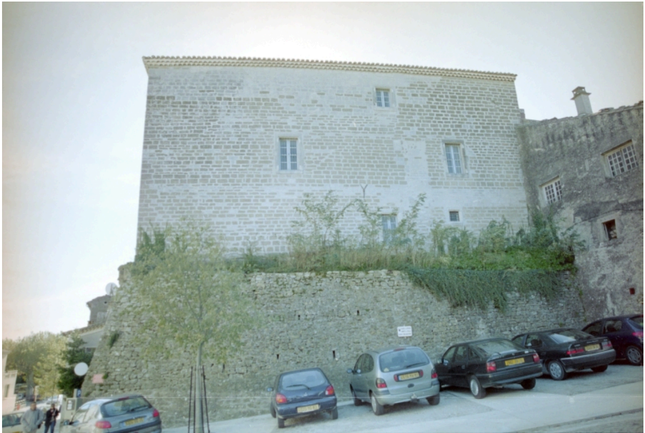
Élévation postérieure sur la rue de l'Hôpital, au-dessus de l'ancienne enceinte.
