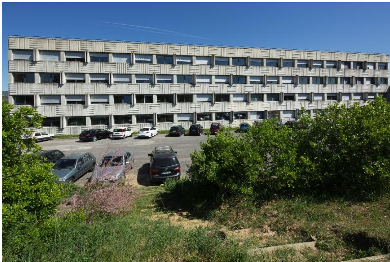
Bâtiment nord : façade ouest.
