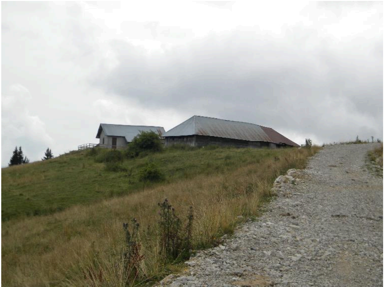
Vue des bâtiments nord depuis la piste d'accès.
