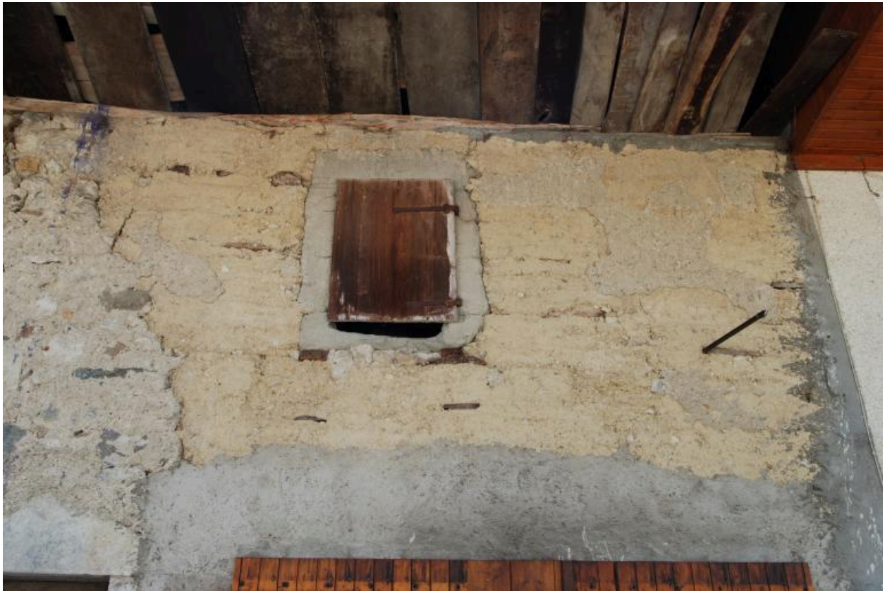
Détail du mur de la grange-étable (pisé).
