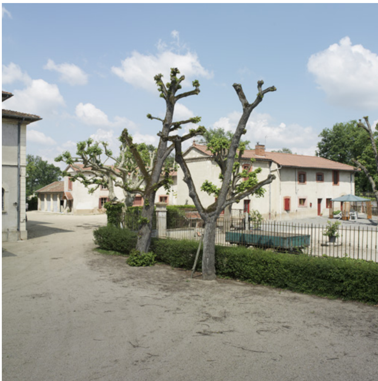
Vue d'ensemble de la cour des communs, depuis le sud-ouest.
