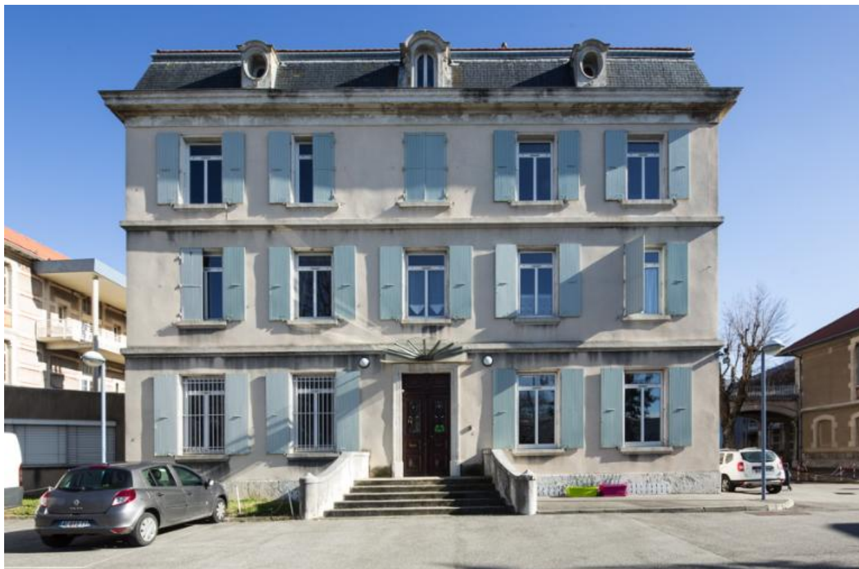
Façade ouest depuis la rue Maurice-Faure
