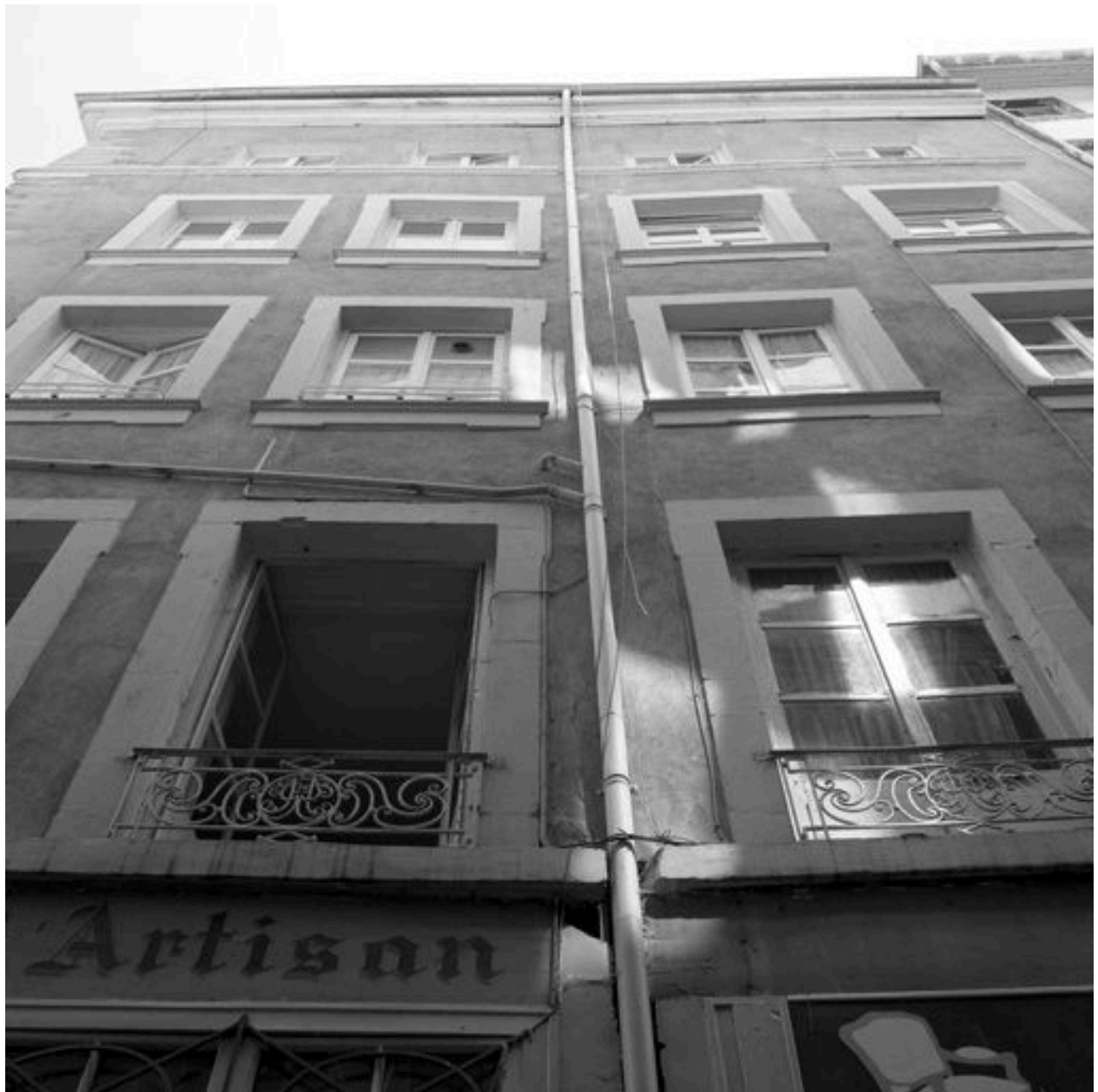
Façade principale rue du Major-Martin, vue générale
